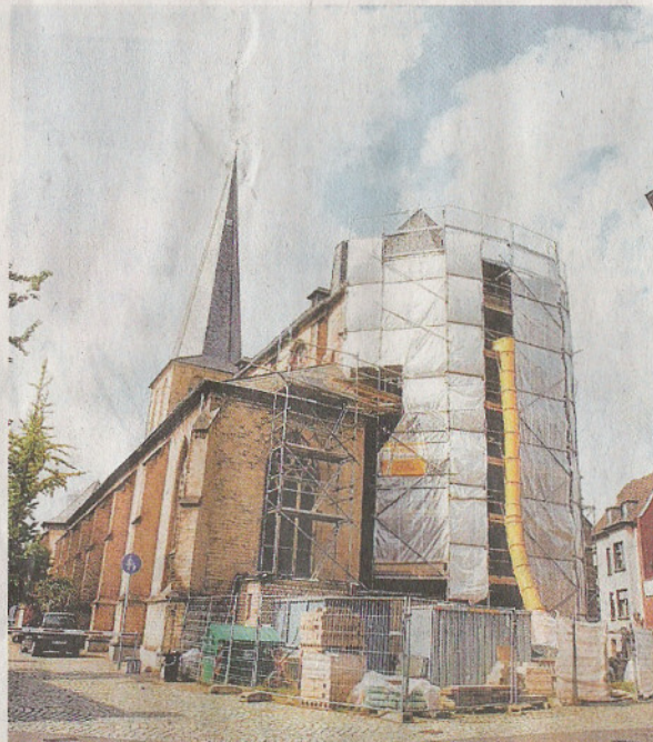
Derzeit ist nur noch der Chor der Citykirche eingerüstet. Hinter den Planen wird gearbeitet. RP-FOTO: DETLEF ILLNER
